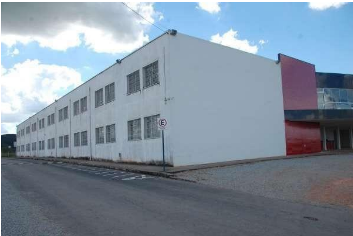
Foto 06 – Fachada lateral – Foto: Reginaldo Silva – 28Mar2018
